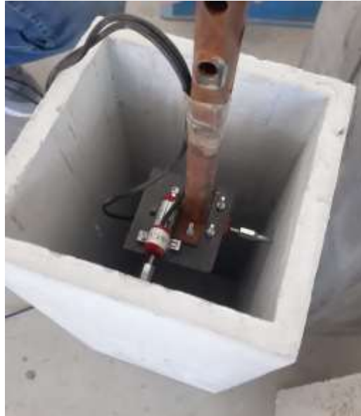
Şekil 3.7 Potansiyometrik Cetvellerin Menfez İçerisindeki Yerleşimi
