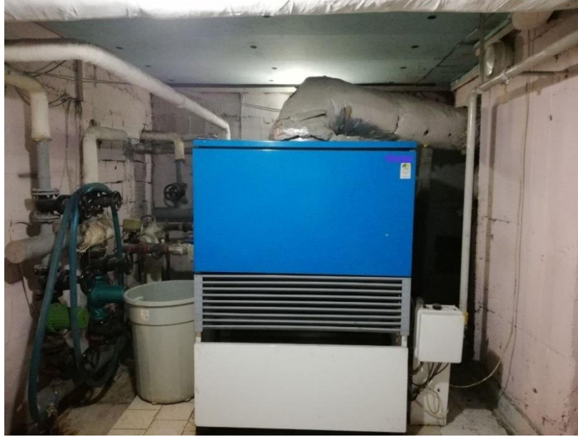
Şekil 1. Patlama senaryoları analiz edilen doğalgaz kazanı
