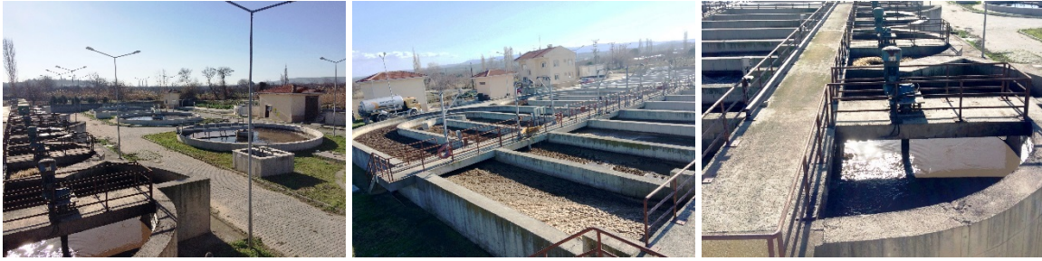
Şekil 2. Kepez kent kanalizasyon atıklarının geri kazanım ve bertaraf edilmesi kapsamında Atık Su Arıtma Tesisi
